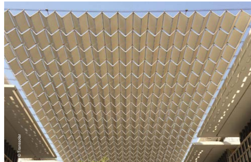
Platzüberdachung der Barahat Al-Nouq Plaza in Doha
